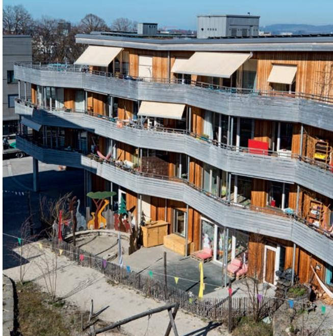
Die Wohnungen im Oberfeld sind eher klein, dafür können die Bewohner Gästezimmer dazumieten (oben links). Tragende Strukturen und die dick isolierten Fassaden sind aus Holz, Treppen und Zugänge aus Brandschutzgründen betoniert. Diese Materialmischung macht die Häuser deutlich leichter als die üblichen 50 Tonnen pro Bewohner und spart somit viel graue Energie. Die Aussenräume sollen möglichst attraktiv sein und werden gemeinsam gepflegt.
