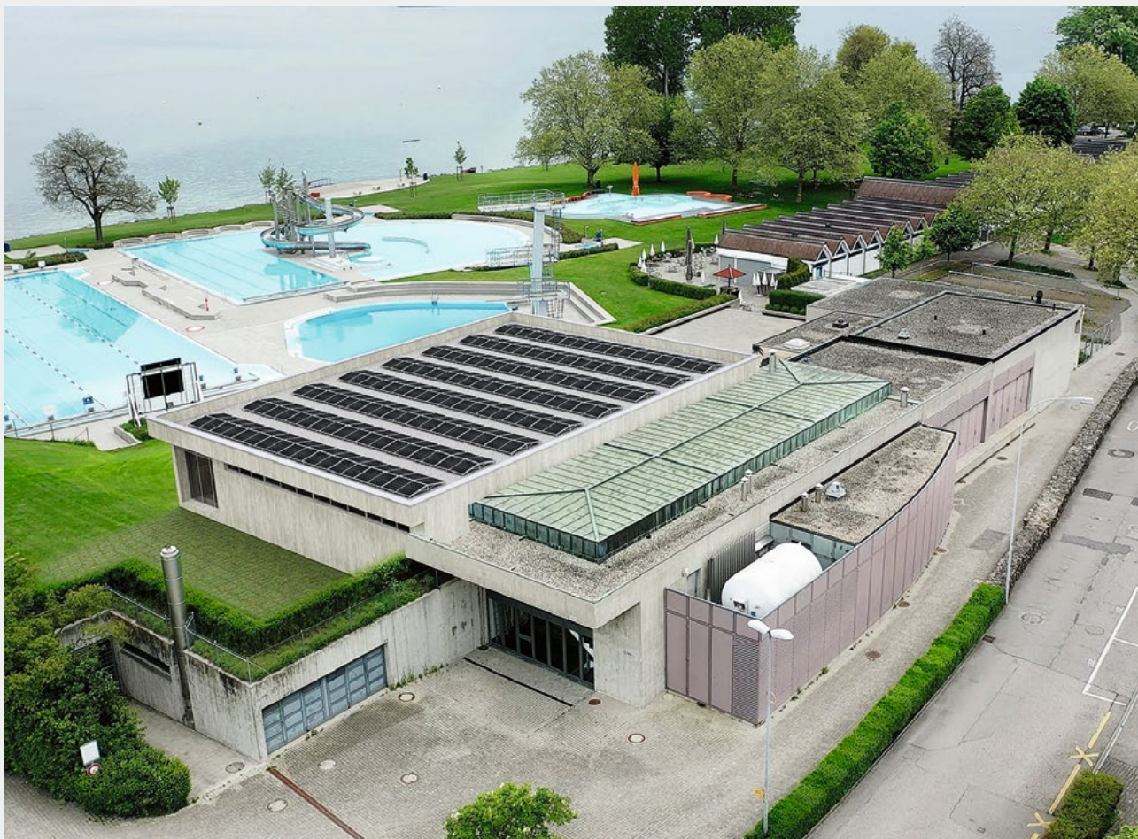
Das Seewasserwerk Arbon, wie auf dem Foto zu sehen, ist mittlerweile umgesetzt. Um die Trinkwasserversorgung von Arbon und Umgebung auch in Zukunft sicherzustellen, wird das Seewasserwerk zurzeit umgebaut, modernisiert und mit einer Ultrafiltrationsanlage ausgestattet. Damit wird eine nachhaltige Lösung für die nächsten Jahrzehnte geschaffen. Die Umsetzung dauert ca. drei Jahre und kostet rund 25 Mio. Franken. Der Umbau ist aktuell in vollem Gange.
