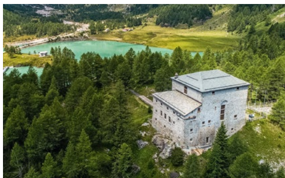
Das Kraftwerk Palü am Berninapass.
